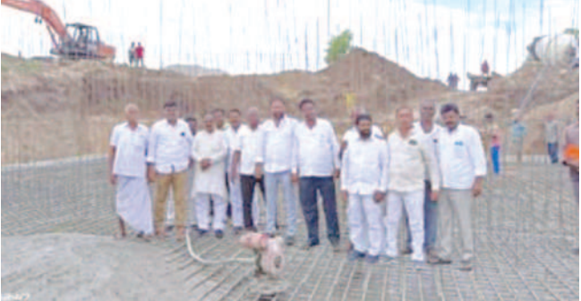
వంతెన నిర్మాణ పనులను పరిశీలిస్తున్న డేవ్లె ఎమ్మెల్యే కాల్ యాదయ్య
